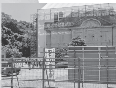
エキスカーション 仁風閣 修理工事中の外観
